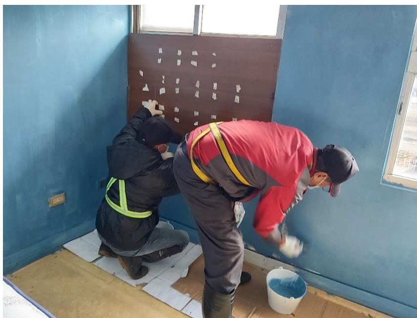
為院生宿舍粉刷牆面
