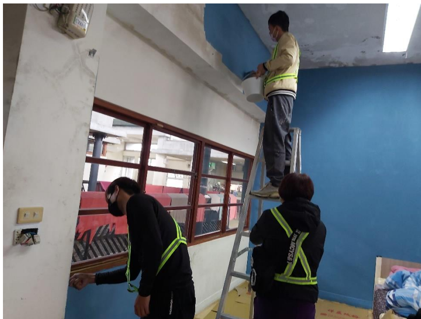
為院生宿舍粉刷牆面
