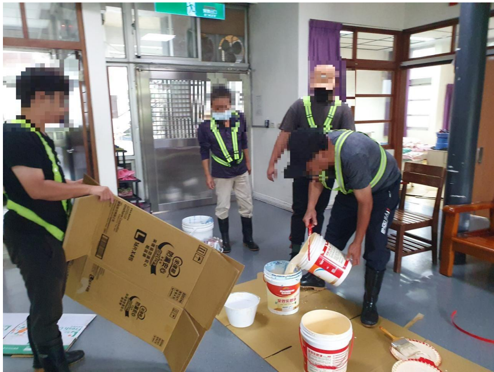
協助宜蘭教養院院生宿舍粉刷牆面
