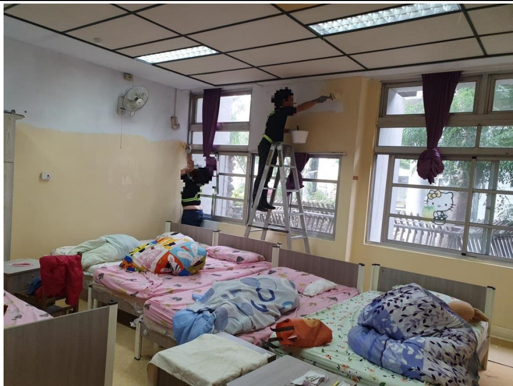
協助宜蘭教養院院生宿舍粉刷牆面
