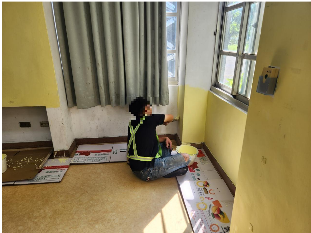
協助宜蘭教養院院生宿舍粉刷牆面
