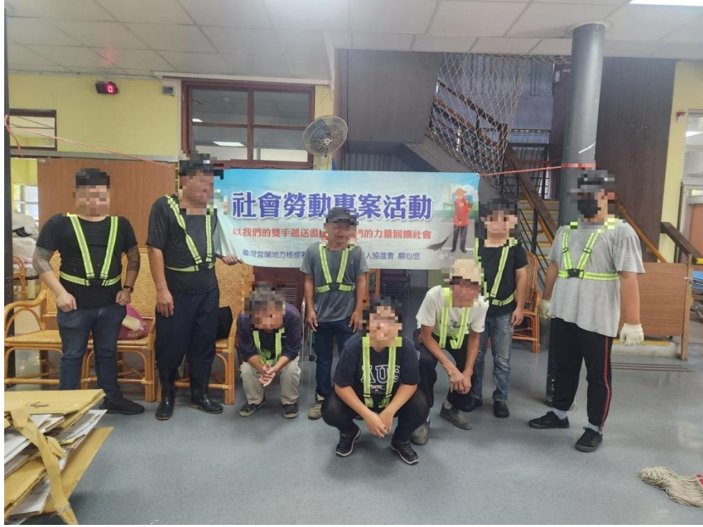
協助宜蘭教養院院生宿舍粉刷牆面
