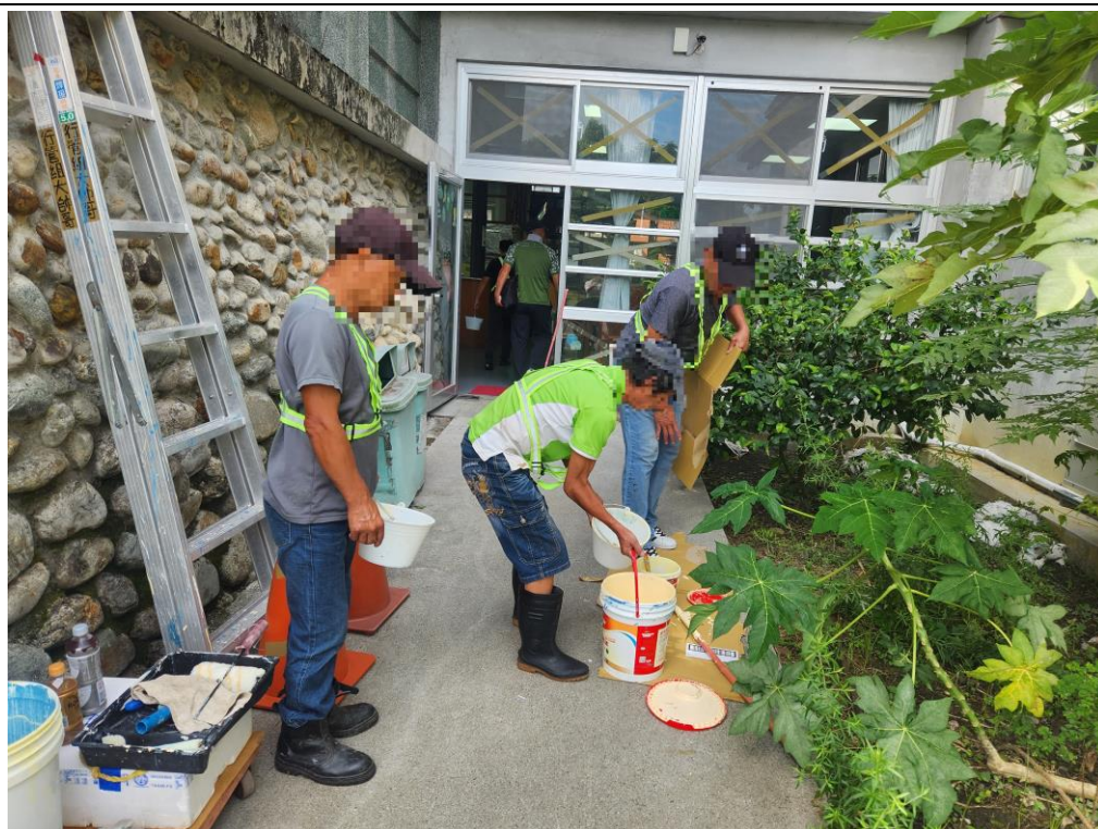
協助宜蘭教養院院生宿舍粉刷牆面
