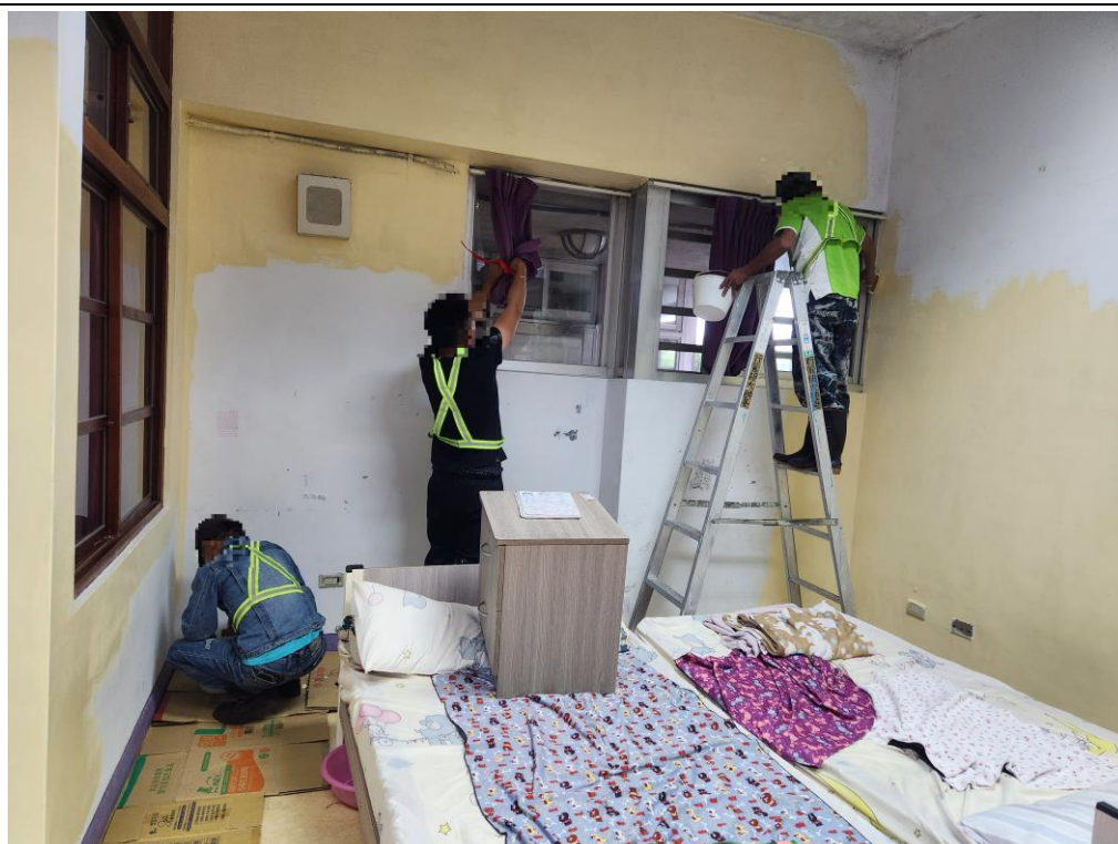
協助宜蘭教養院院生宿舍粉刷牆面
