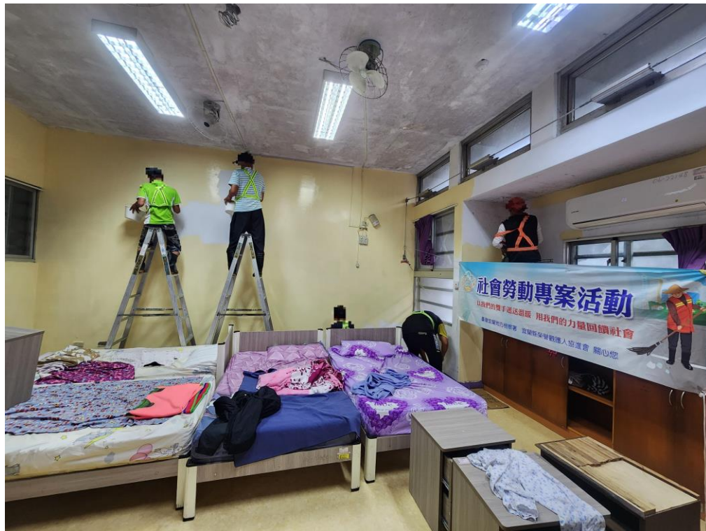
協助宜蘭教養院院生宿舍粉刷牆面
